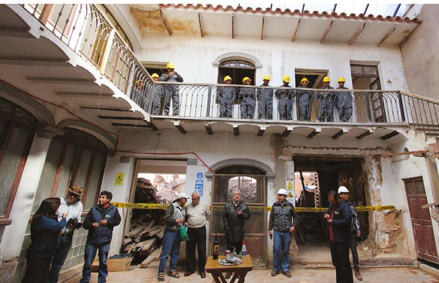
Tres momentos de las obras de ampliación de la Casa de la Libertad en Sucre.
